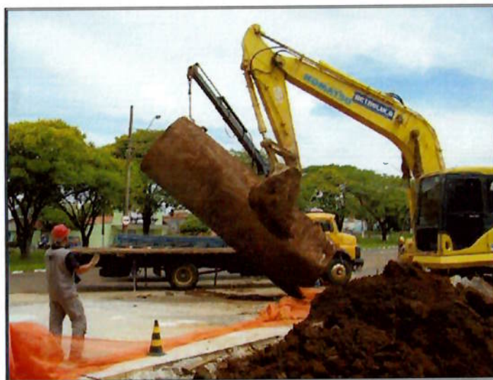
Foto 23: Tanque sendo içado para o caminhão.
