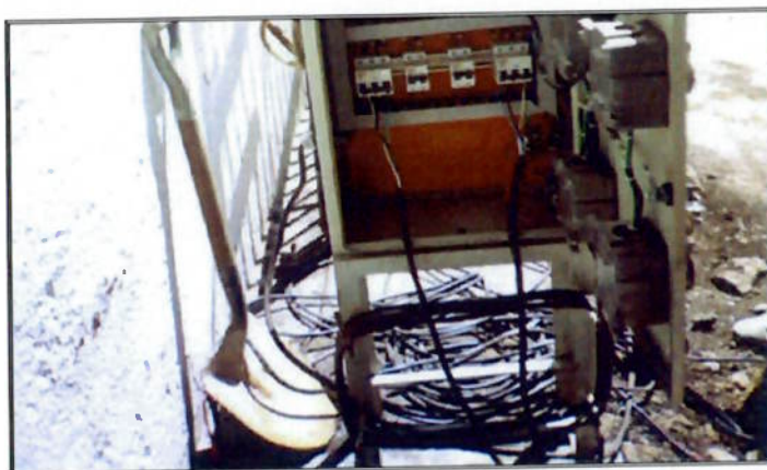
Foto 6: Quadro elétrico (provisório).
