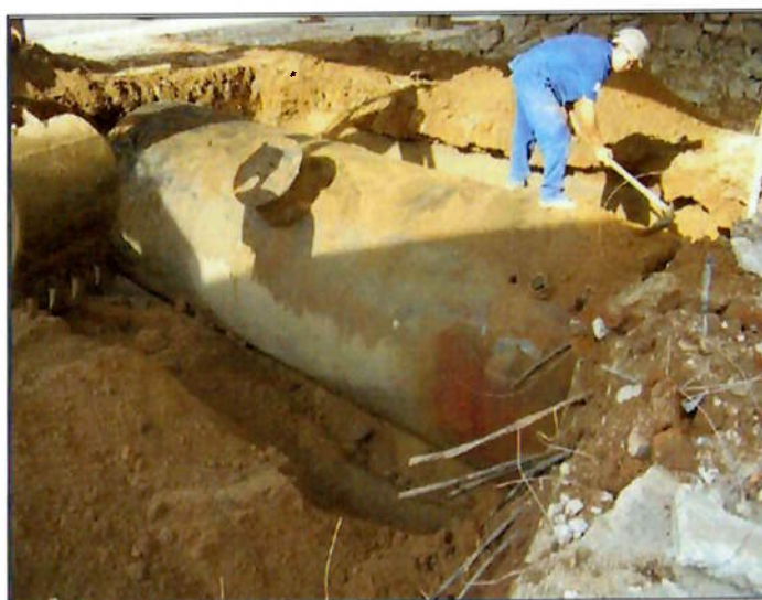
Foto 12: Limpeza do tanque e tamponamento das conexões.
