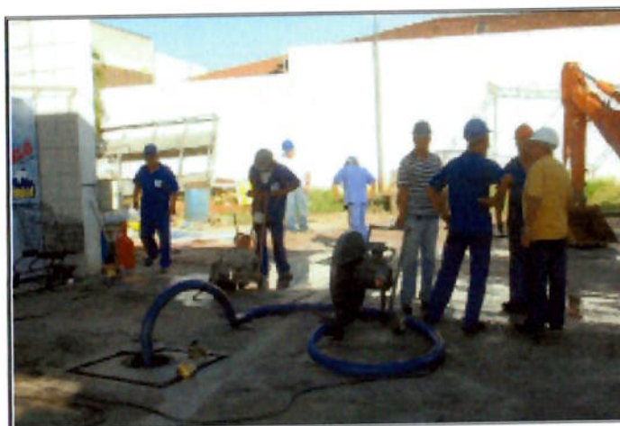
Foto 7: Momento da desgaseificação através de exaustão.
