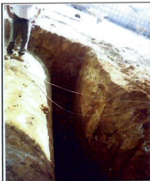
Foto 4: Passagem de cabos elétricos energizados Fonte: O Autor.
