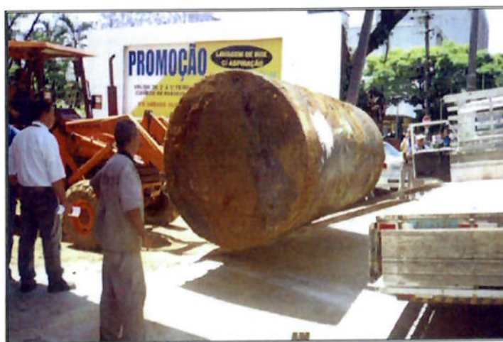
Foto 20: Tanque sendo empurrado para o caminhão
