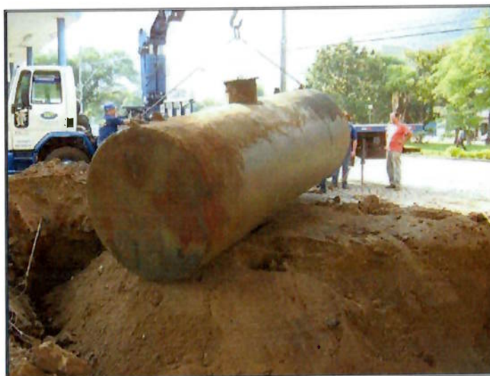
Foto 15: Vista do içamento com cabo de aço.
