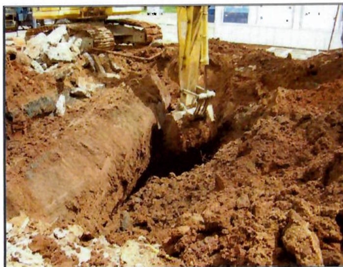
Foto 11: Abertura da cava para posterior remoção do tanque.
