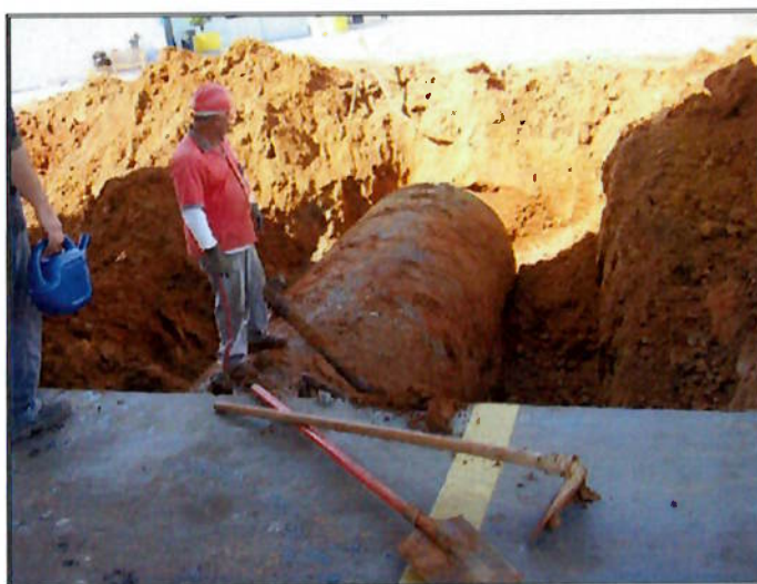
Foto 13: Limpeza do tanque e tamponamento das conexões. Fonte: O autor.
