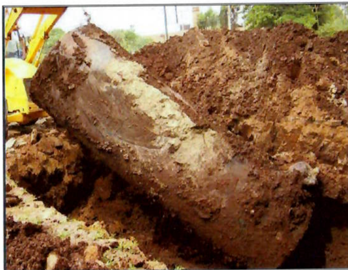
Foto 14: Vista da retirada do tanque.
