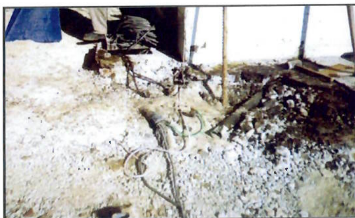
Foto 5: Fiações energizadas expostas. Fonte: O Autor.
