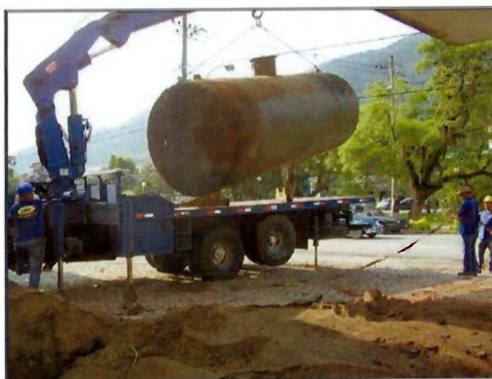
Foto 16: Momento do içamento do tanque. Uso de equipamento adequado.
