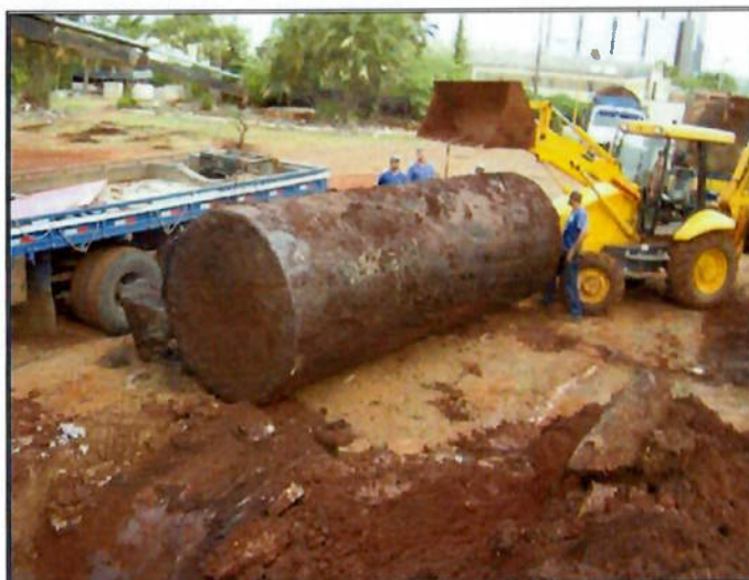
Foto 17: Tanque fora da cava aguardando o içamento para o caminhão. Fonte: O Autor.
