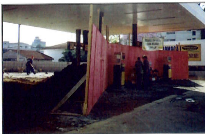
Foto 2: Área de trabalho com detalhe do isolamento.
