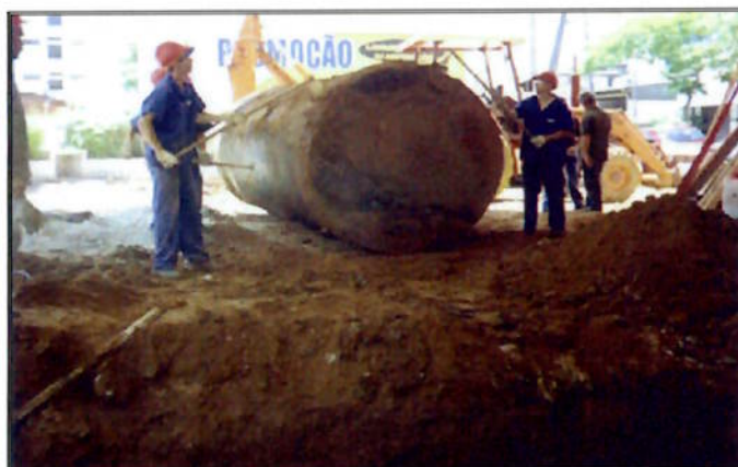
Foto 18: Trabalhadores efetuam a limpeza do tanque com enxadas. Fonte: O Autor.
