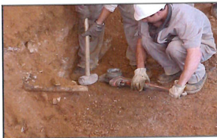
Foto 8: Momento da retirada as conexões para posterior tamponamento das mesmas. Fonte: O Autor.
