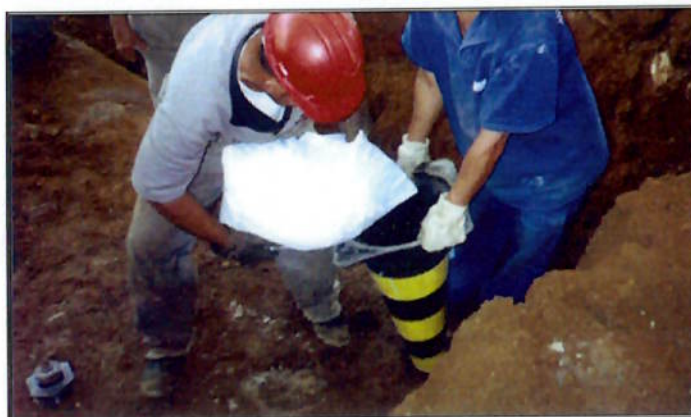
Foto 9: Introdução do dióxido de carbono sólido (gelo seco) no interior do tanque.
