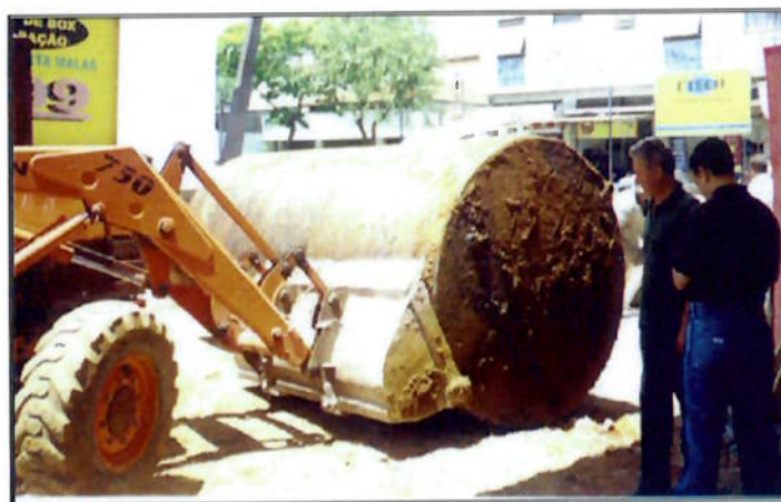
Foto 19: Tanque posicionado para ser colocado no caminhão.
