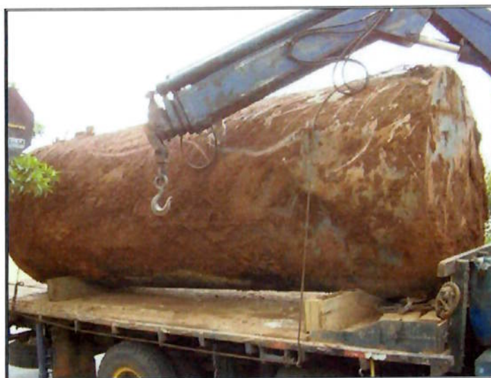
Foto 24: Tanque calçado e com os bocais virados para cima.
